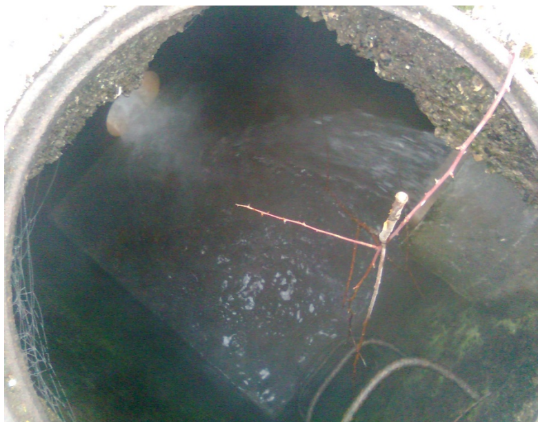
Sa zadnje strane mljekare Nika nalazi se otvor iz kojeg otpadne vode idu direktno u Bisticu
