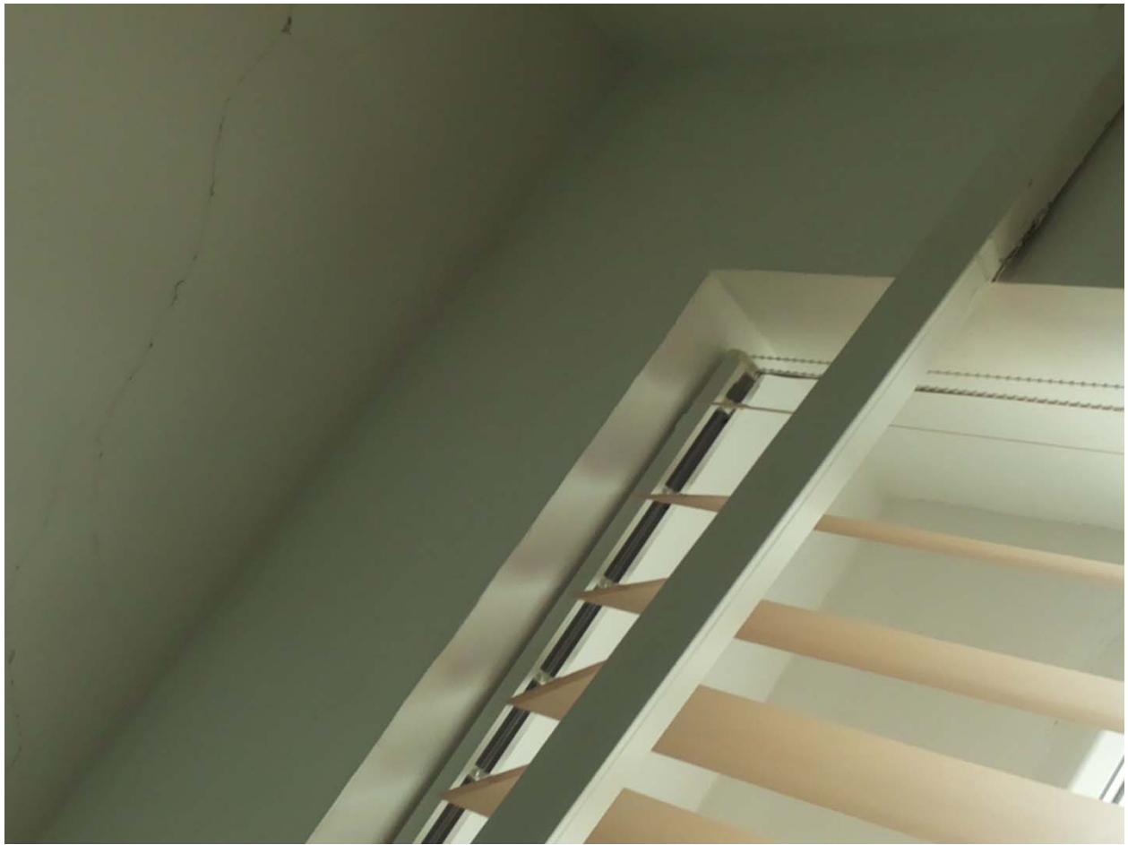
Raspuknuti plafon apoteke u staroj zgradi
